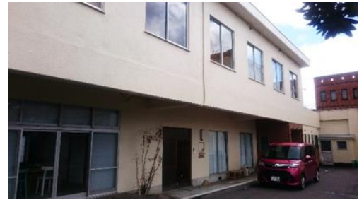
空き家を改修したサテライトオフィス
