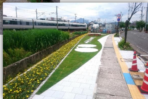
整備後の舟津神社前
