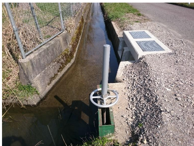
オーバーフロー排水柵が設置された用水
